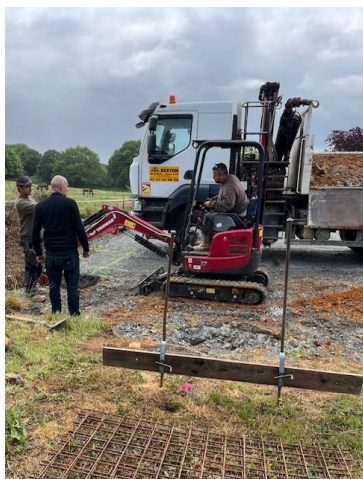
Une préparation du terrain
