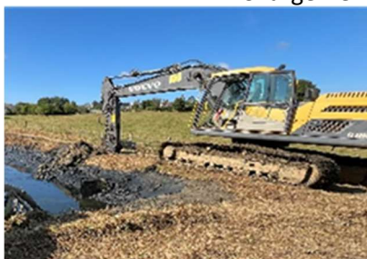
Re-profilage des talus
