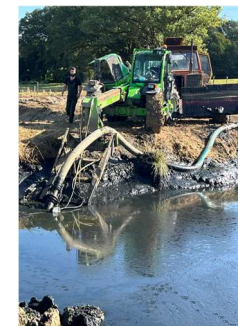
Pompage des boues
