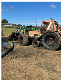
Mise en place du chantier
