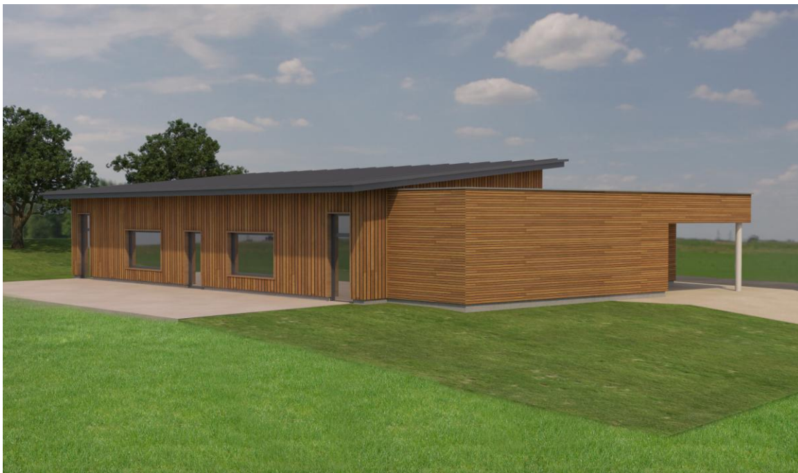
Façades côté sud et rue Chauvelier
