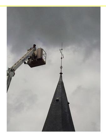
En un tour de main, l'entreprise Toqué d'Epineu Le Chevreuil a réparé le tout et réalisé l'entretien général de la toiture (démoussage, nettoyage des descentes d'eau ainsi que le remplacement d'ardoises)
